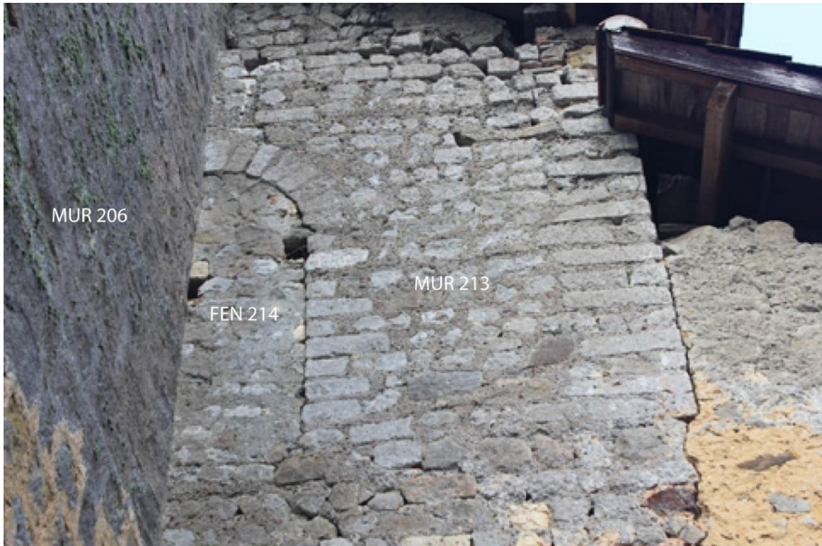
Fig. 21 - Vue de la fenêtre ouverte au chevet de l'église Saint-Pierre
