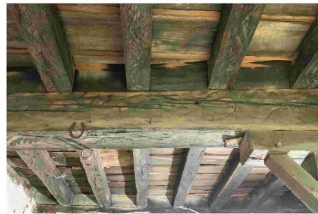
Plafond à la française avec décor polychrome en rez-de-chaussée
