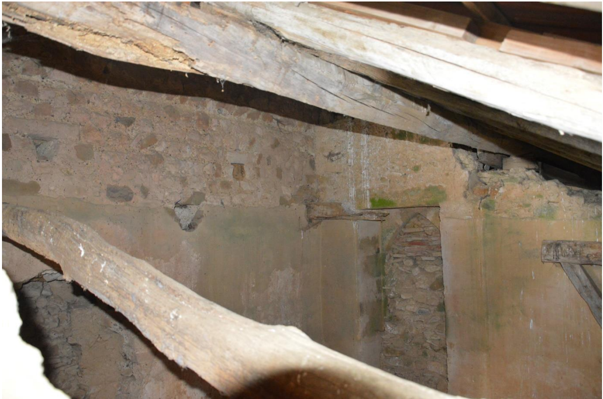
Fig. 48 - Porte ouverte dans le dernier niveau du bâtiment nord
