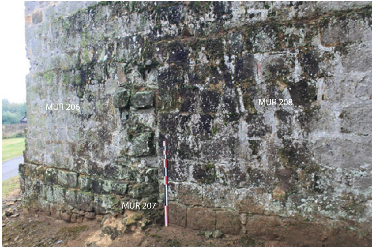
Fig. 49 - Mur chemisé par la construction de la tour-clocher
