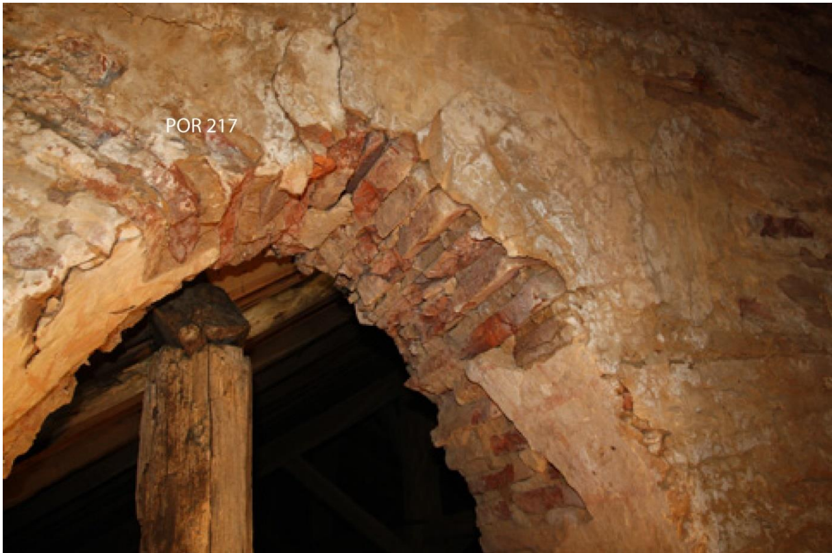
Fig. 35 - Arc brisé de la porte
