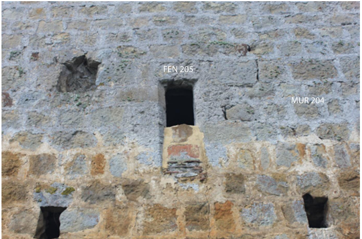
Fig. 55 - Fenêtre aménagée dans le mur est de la tour-clocher
