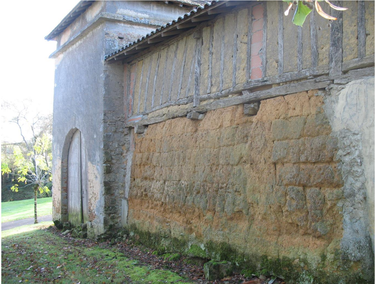
Fig. 13 : Photographie du mur en terre massive et de la porte visibles à l'extrémité nord de plate-forme du Castet, prise depuis le nord (cliché : N. Guinaudeau)
