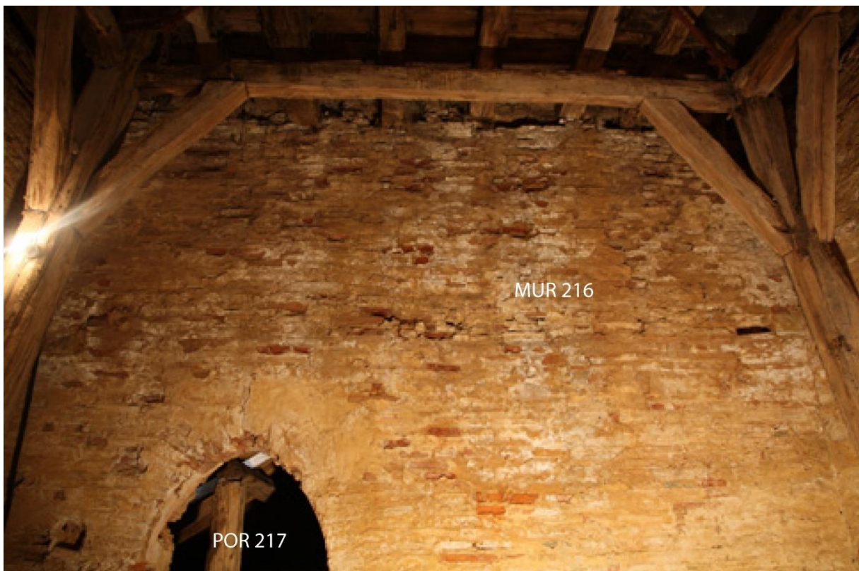
Fig. 33 - Surélévation du mur de chevet en maçonnerie de briques
