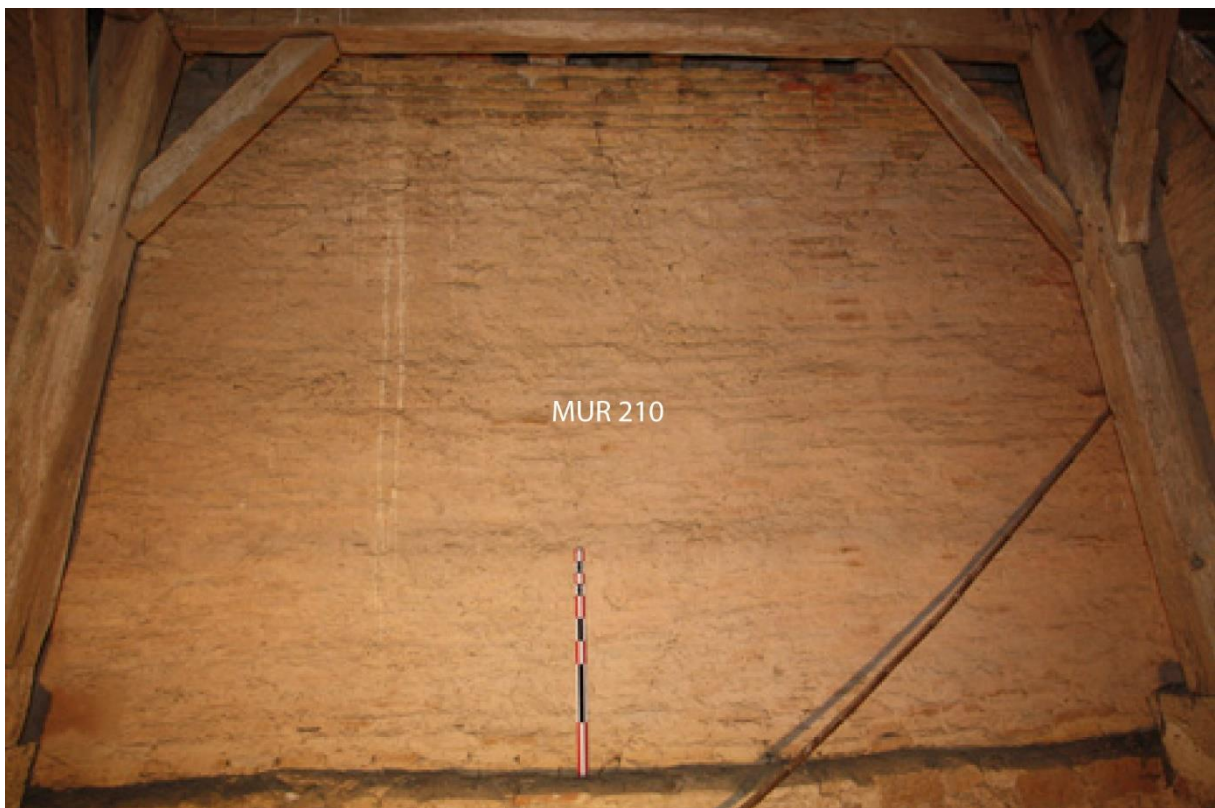
Fig. 60 - Mur est de la surélévation de la tour-clocher en maçonnerie de briques
