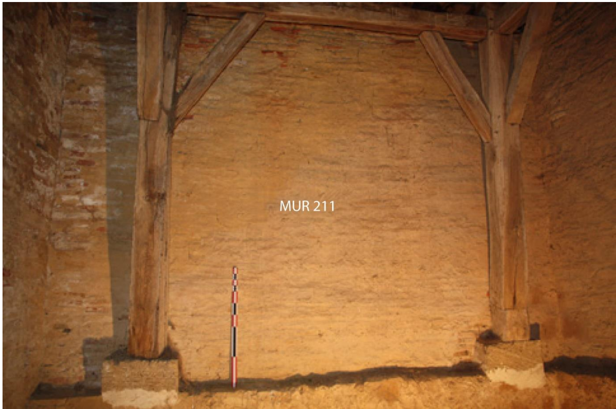
Fig. 59 - Mur nord de la surélévation de la tour-clocher en maçonnerie de briques
