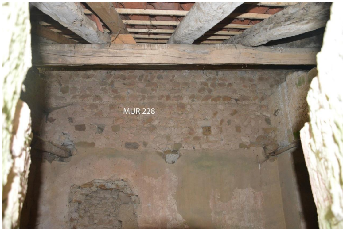
Fig. 25 - Parement extérieur du mur gouttereau nord de l'église Saint-Pierre
