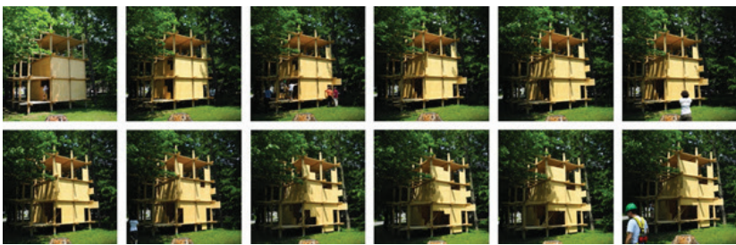
Référence de prototype réalisé à l'école d'architecture de Laval, Québec, proposant différentes configurations spatiales pour analyser et simuler les variations d'ambiances thermiques et lumineuses 9 . ECHASON permettra de simuler des situations d'écoute au moyen d'enceintes situées dans « l'échafaudage » ou à l'extérieur.
