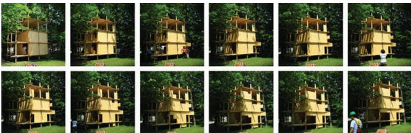
Référence de prototype réalisé à l'école d'architecture de Laval, Québec, proposant différentes configurations spatiales pour analyser et simuler les variations d'ambiances thermiques et lumineuses<sup>9</sup>. *ECHASON* permettra de simuler des situations d'écoute au moyen d'enceintes situées dans « l'échafaudage » ou à l'extérieur.
