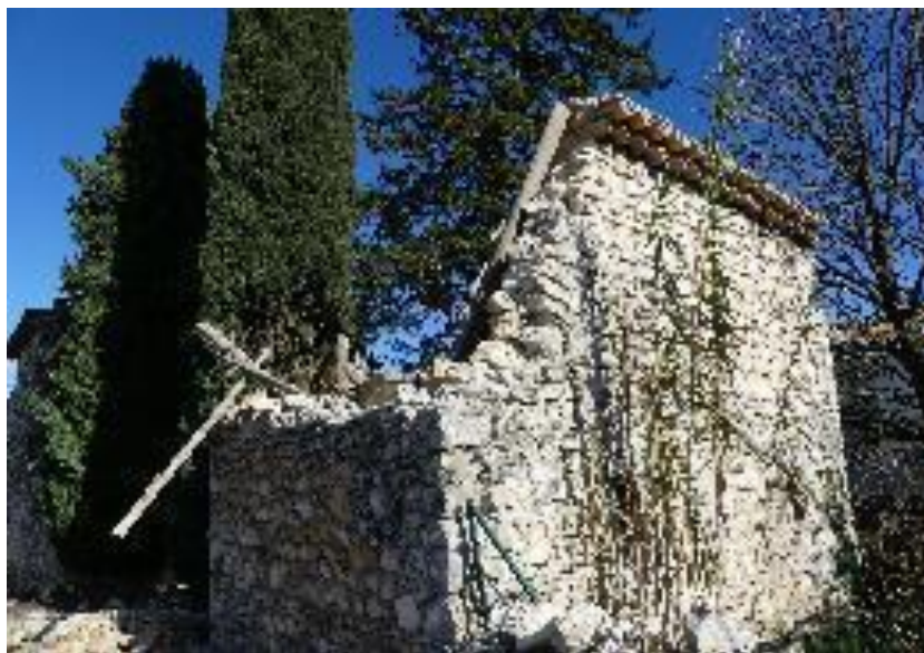
Figure 6-6 : Bâtiment de corps de ferme en maçonnerie de pierre non chaînée à proximité de la Rouvière.
