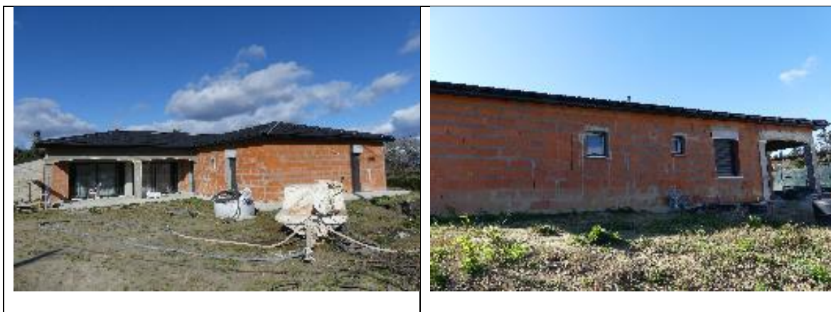
Figure 6-5 : La Rouvière, exemple de maison individuelle de type rez-de-chaussée en maçonnerie de brique simple en construction sans dégât apparent.
