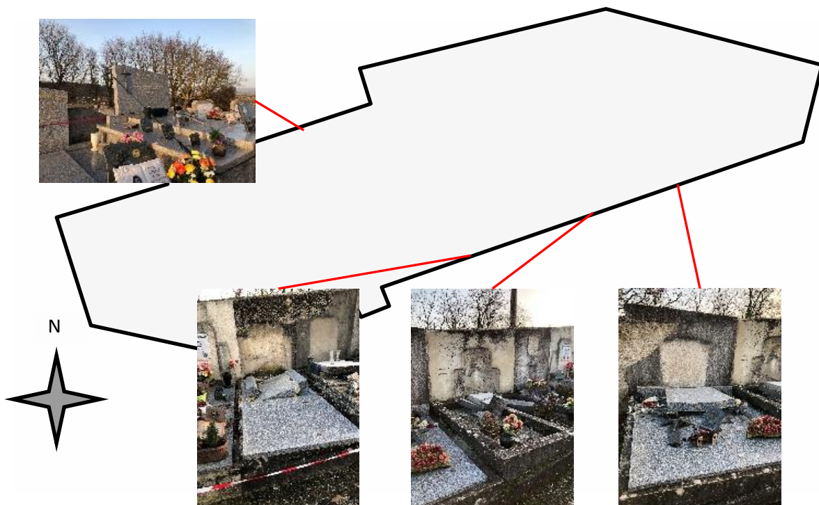
Figure 6-35 : Cimetière du Frayol – basculement de stèles.
