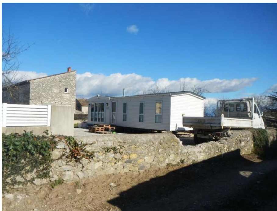
Figure 7-7 : Installation d'un mobil-home à la Rouvière, le temps des travaux de reconstruction.
