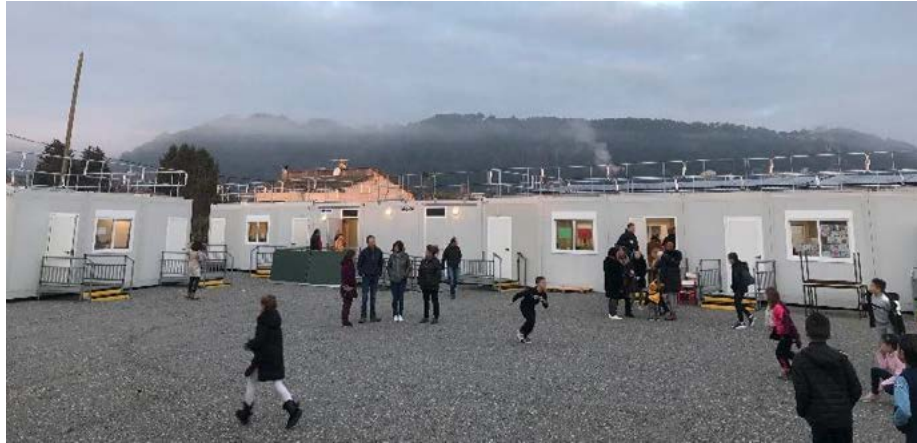
Figure 7-17 : Bâtiments modulaires remplaçant l'école Frayol-Haut, source www.mairie-le-tel.fr .
