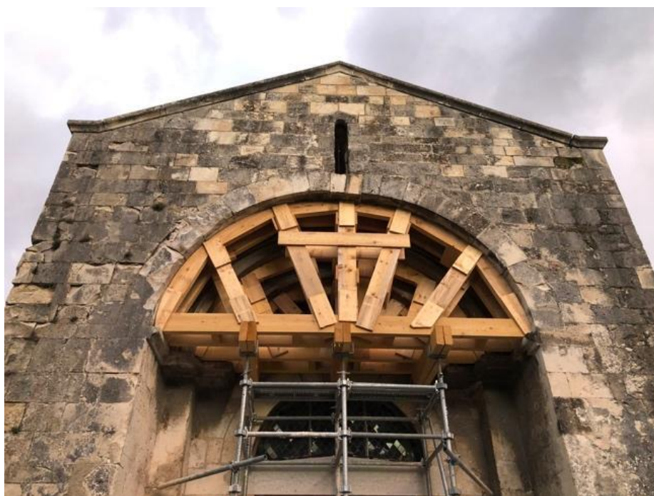
Figure 6-45 : Dommages sur les voissures du portail.
