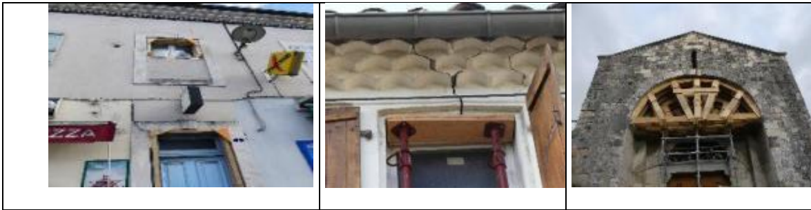
Figure 5-2 : Étalement provisoire de linteaux ou voutes (Eglise de Mélas).
