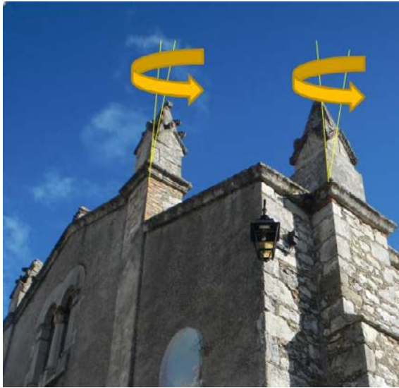
Eglise de Saint-Thomé - Les décorations en forme de pyramide ont pivoté sur leur socle d'environ 20°
