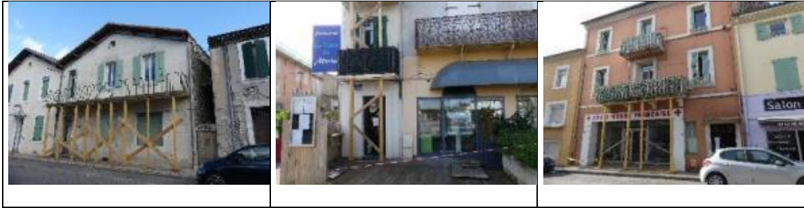
Figure 5-1 : Étalement provisoire de balcons.
