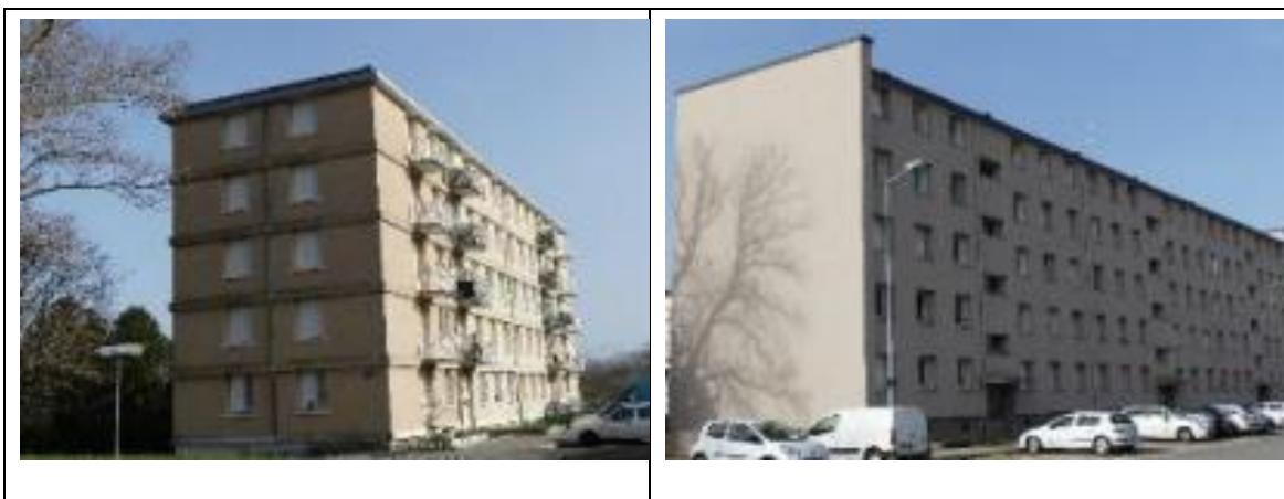
Figure 6-11 : Exemple de bâtiment en béton armé R+4 -collectif habitation, rue Adrien Jouve, quartier Frayol.
