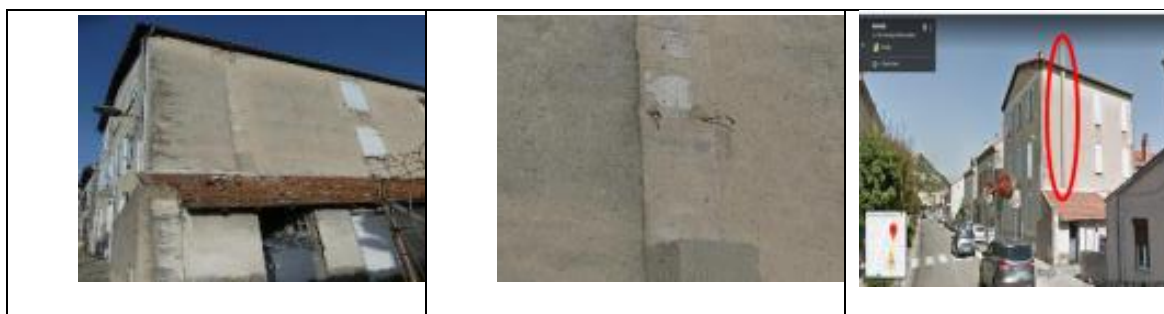
Figure 6-30 : Cheminée désolidarisée du bâtiment; à droite photo « Google Street view » avant séisme.
