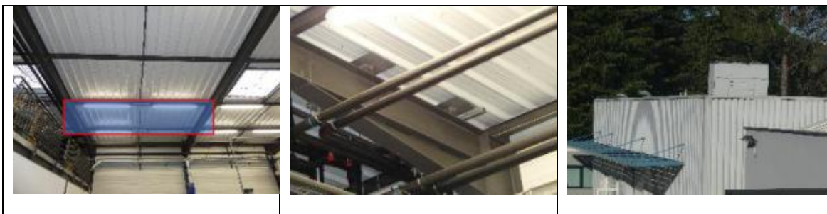
Figure 6-20 : De gauche à droite : vue sur les 2 portiques métalliques concernés ; dispositif de supportage sur portique; emplacement de la pompe à chaleur sur la toiture.
