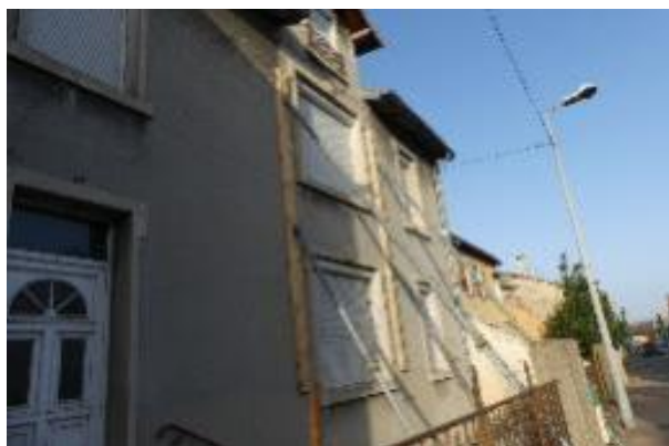
Figure 5-6 : Tenue de façade avec des étais en tube métallique élancé.
