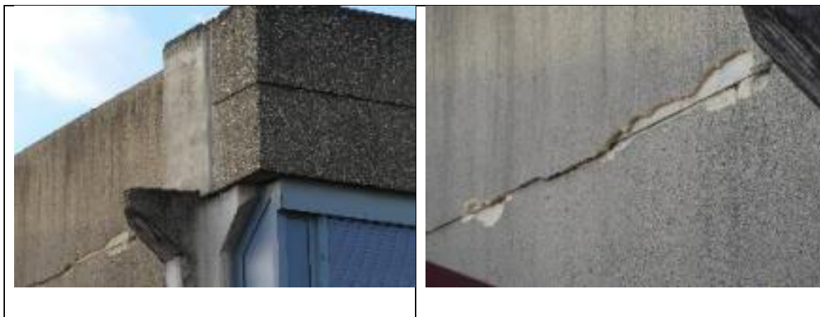
Figure 6-26 : Vue d'une poutre préfabriquée et du déplacement différentiel entre celle-ci et l'infrastructure.
