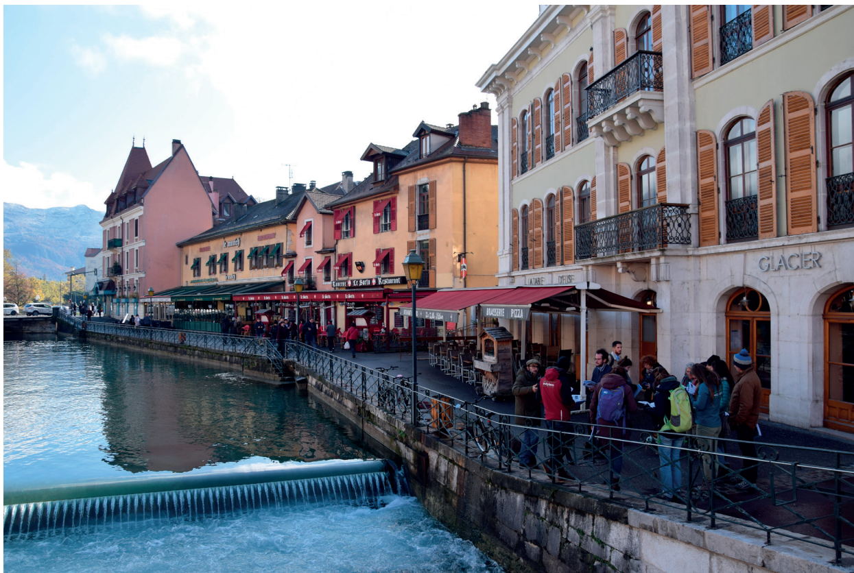
Figure 7 – Troisième intervention de l’excursion devant la vanne du Thiou, Annecy, novembre 2019. Cliché : Mélanie Duval.
