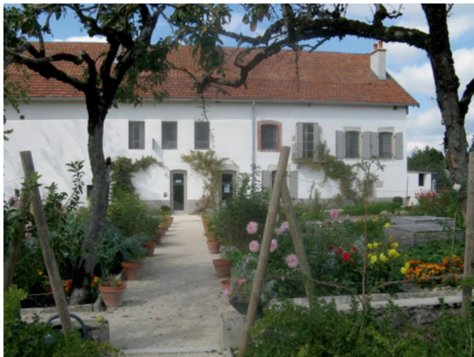
Figure 2. La Ferme Courbet réhabilitée.
