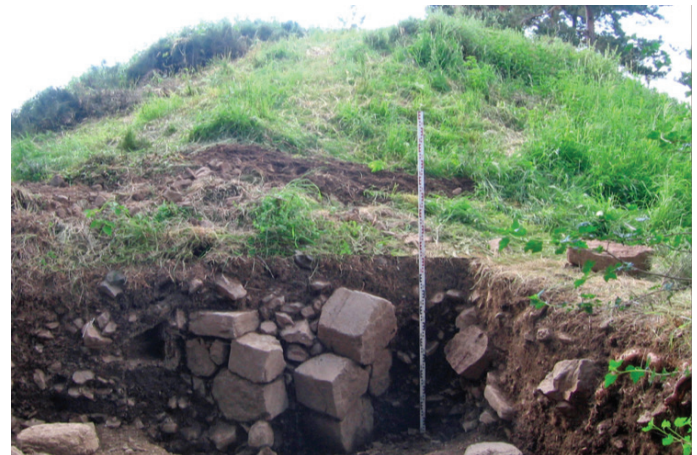
Fig. 7. Parement de l'entrée composée de prismes basaltiques, Camp d'Antoune (43-Salettes), cliché M.-C. Kurzaj.
