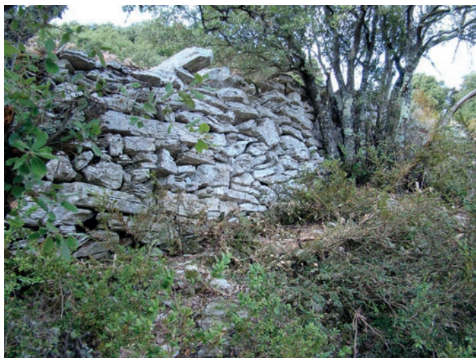
Fig. 9. Le parement externe de la muraille dans son tronçon sud-est. Cliché A. Gorgues, 2009.
