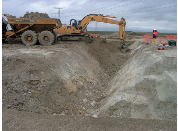
Fig. 4. Vue du fossé de Batilly-en-Gâtinais, Les Pierrières (Loiret), en cours de fouille mécanique (fouilles S. Liégard, Inrap; cliché S. Liégard).
