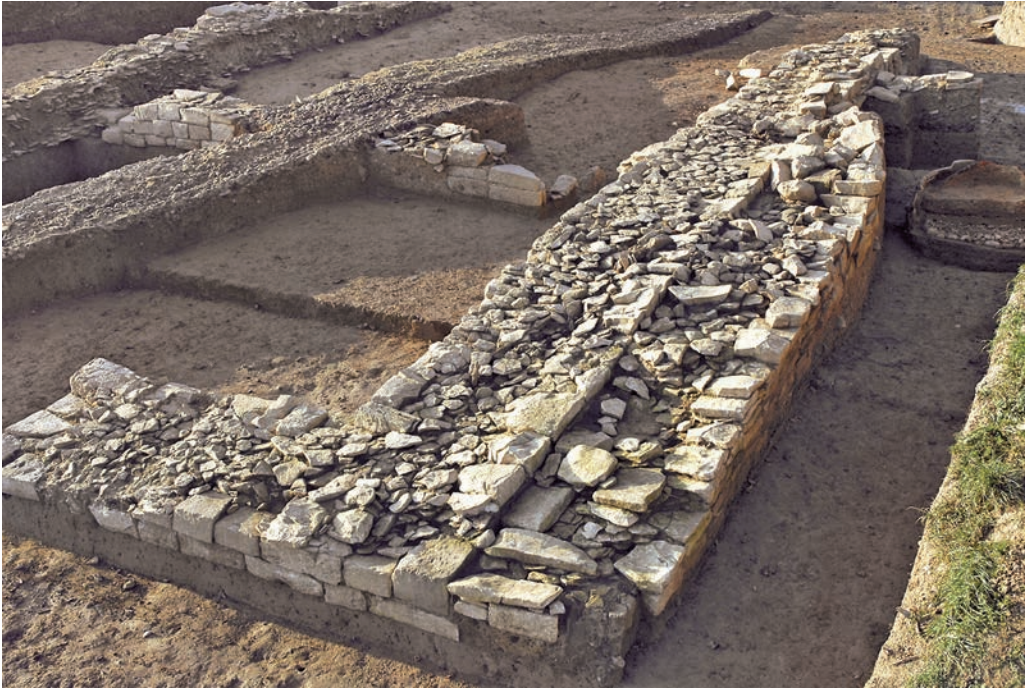
Fig. 2. Soubassement en pierre : paroi est et mur parallèle ayant supporté un escalier (R. Hajdu © Landesamt für Denkmalpflege im RP Stuttgart).
