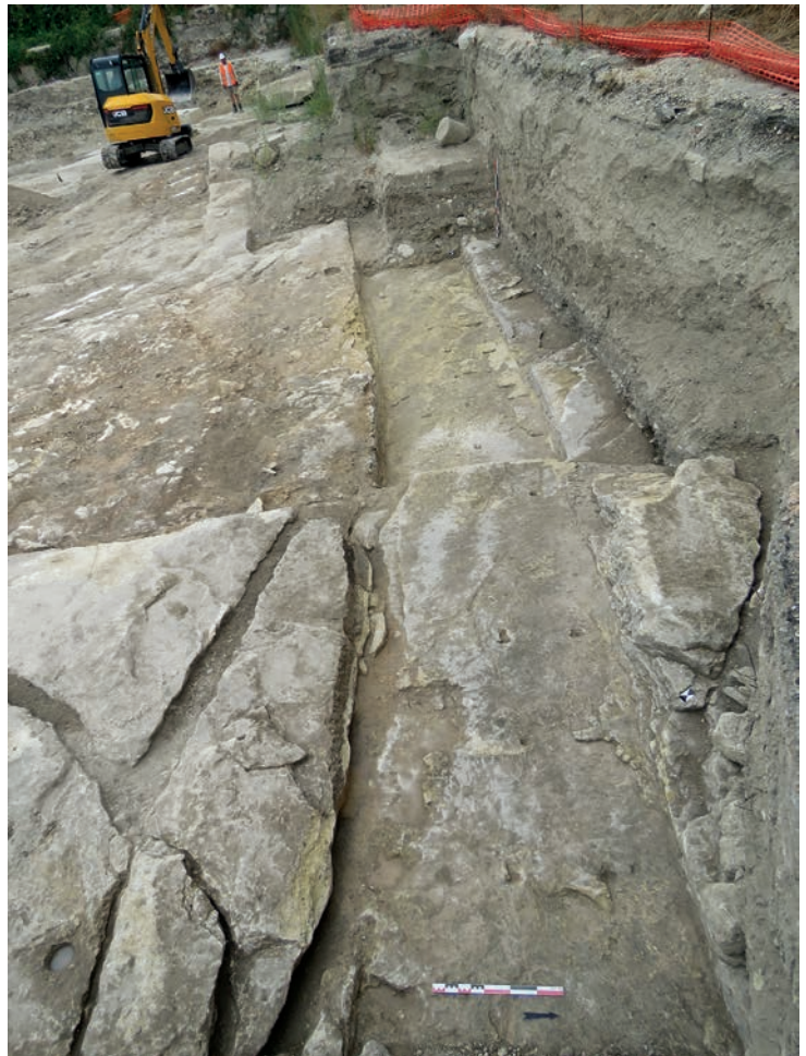
Fig. 3. Le creusement d'installation du rempart (ici vu depuis l'est) a livré plusieurs indices permettant de restituer la disposition des blocs de la première assise. On remarque au premier plan, un double alignement de trous de pince qui coïncide à cet endroit avec la légère inflexion de l'ouvrage (cliché G. Vincent/Inrap).
