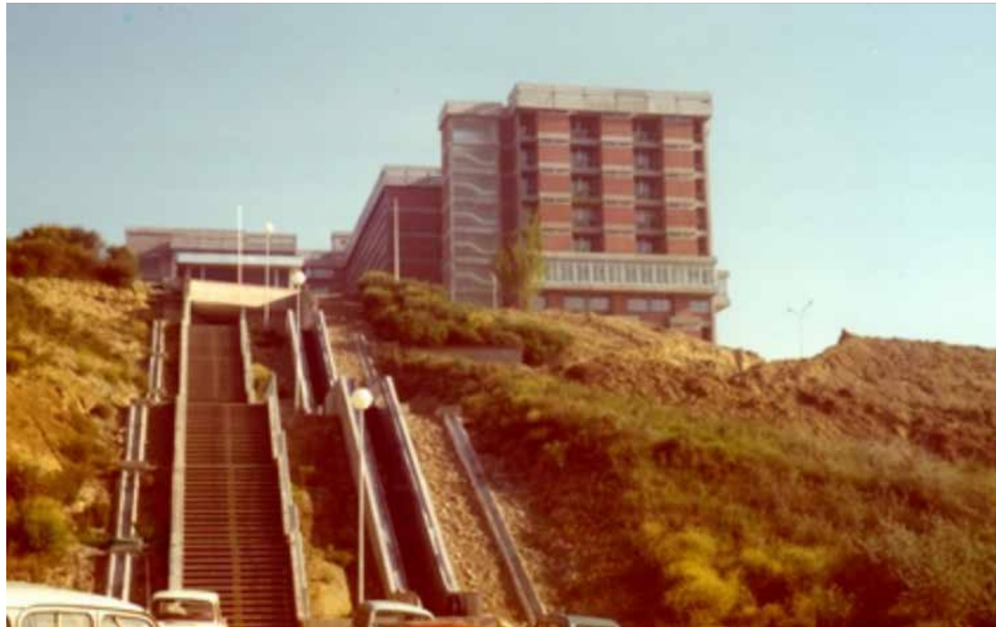
Fig. 2 : Accès piétons au CHU de Rangueil, 1967-1974, Le Maresquier et de Noyers arch. Ces monumentaux propylées convenaient-ils aux consultants ?
