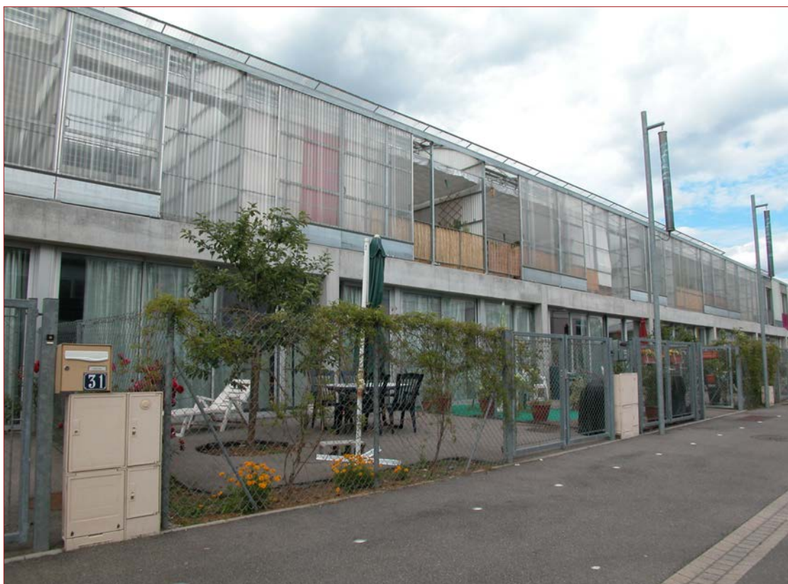
1. Série Lacaton-Vassal : vue depuis le passage des lauriers
