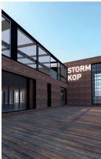
BRIQUE EXISTANTE Une réutilisation de la brique
