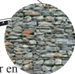
Mur en gabion
