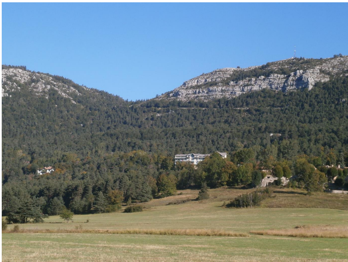
Thorenc et son ancien Palace Hôtel, vu depuis la route principale d'accès
