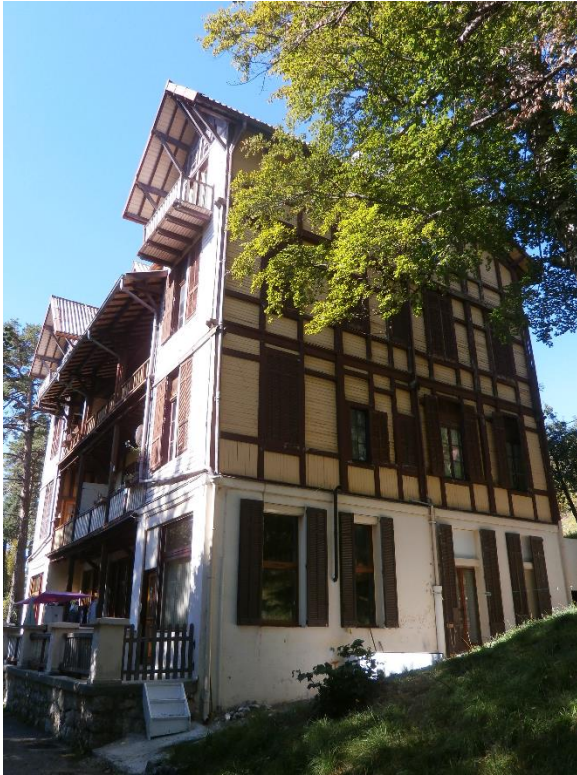
Vue latérale de l'ancien Grand Hôtel des Alpes
