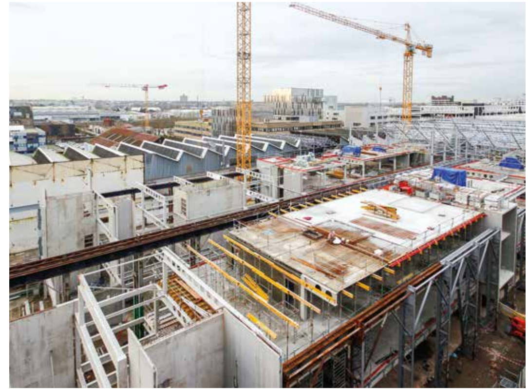
Réhabilitation des halles Alstom, halle 5, chantier de l'ESBANM (école des beaux-arts), janvier 2016. © Photo Valéry Joncheray / Samoa.
