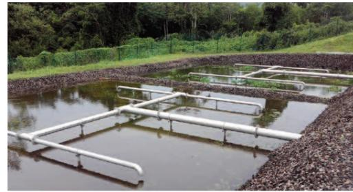
Figura 13. Inundación de los filtros de la estación de Taupinière durante la tormenta Matthew. Son los filtros de la 2ª línea de la estación que todavía no están en servicio y, por lo tanto, no han sido plantados por falta de carga suficiente.
