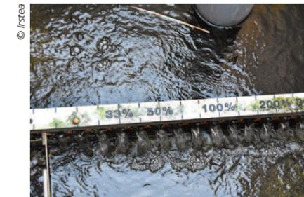
Figura 6. Lámina dentada para recirculación manual.
