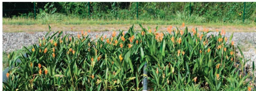
Figura 24. Filtro plantado con *Heliconia psittacorum*.
