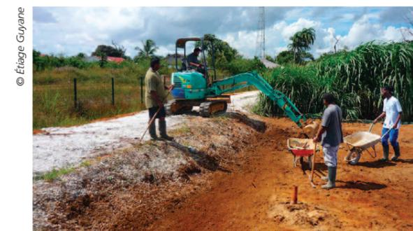
Figura 11. Operación de extracción de lodos en Bois d'Opale 1, Guyana. Estos lodos pueden ser valorizados en agricultura (Epnac, 2014).
