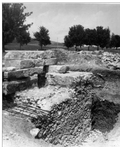
Figure 16. Ci-dessous : Le sondage de la fondation en cours de remplissage et le ferrillage de la semelle en béton.
