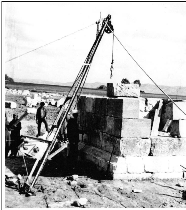
Figure 12. A gauche : Levage avec un tripode bricolé sur le modèle des mâts romains.
