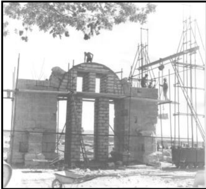
Figure 17 : Le remontage de l'arc.
