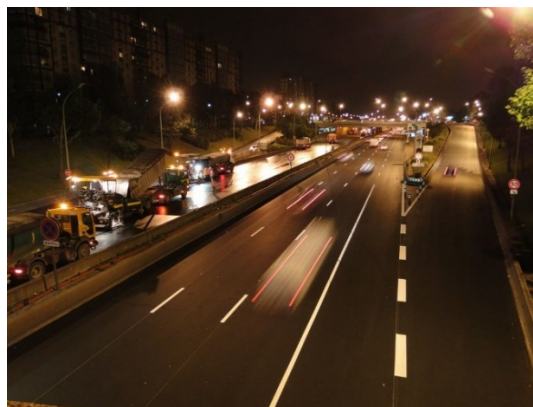
Figure 4 : Mise en place d'enrobés acoustiques Porte de Vincennes –Juin 2012 (crédit Ville de Paris)
