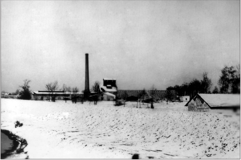
Les bâtiments du camp de Bobrek sous la neige, hiver 1944. Photographie d'un ingénieur allemand.
