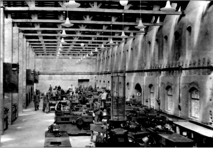
La salle des tours de l'usine Siemens à Bobrek. Photographie d'un ingénieur allemand. 1944.
