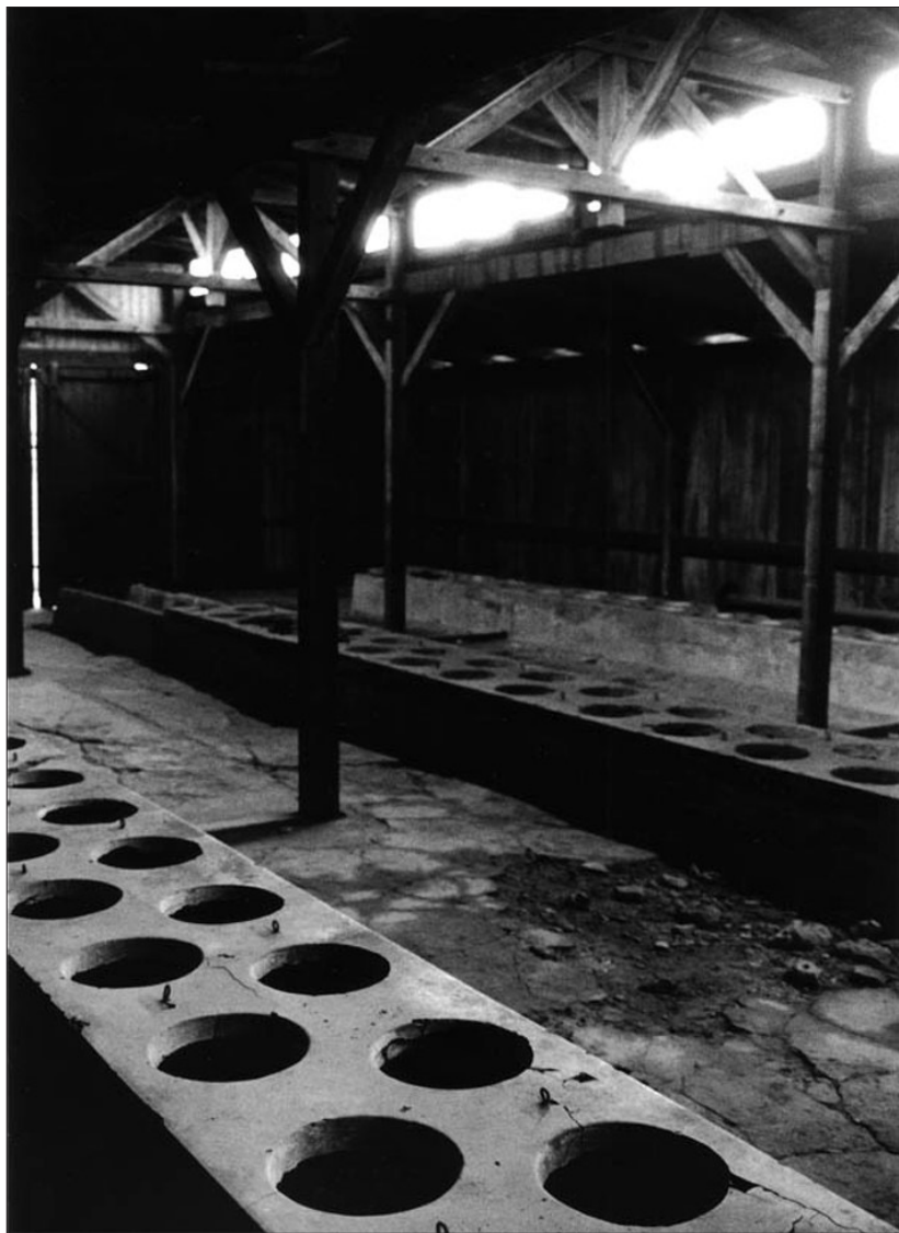
Intérieur du Block des latrines collectives du camp des hommes d'Auschwitz II-Birkenau. Photographie de 2005.
