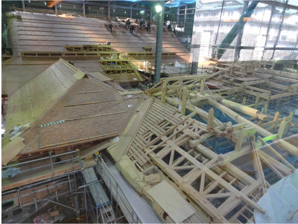
Figure 8 : a : le donjon du château d'Osaka en béton ; b : celui du château d'Hiroshima en bois selon les techniques traditionnelles ; c : le palais honmaru du château de Nagoya en cours de reconstitution.
