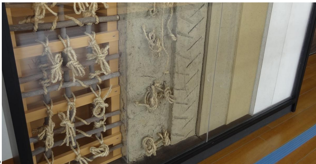
Figure 3 : a : vue de face des différentes couches constituant un mur (7 au total) ; b : vue de biais permettant de voir leurs épaisseurs.
