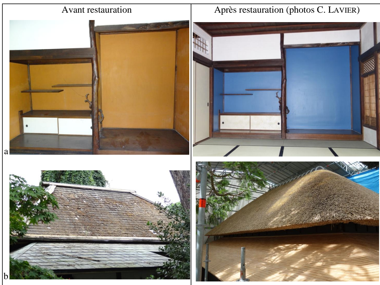
Figure 7 : a : tokonoma 5 et tokowaki 6 du pavillon Ouest ; b : toiture du pavillon Ouest.
