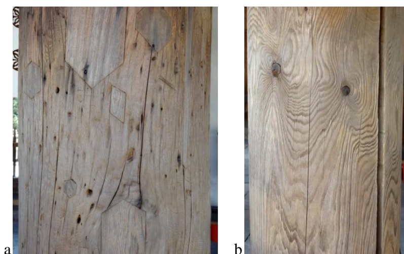
Figure 5 : a : poteau en bois ancien avec des parties restaurées ; b : poteau intégralement remplacé lors d'une restauration.
