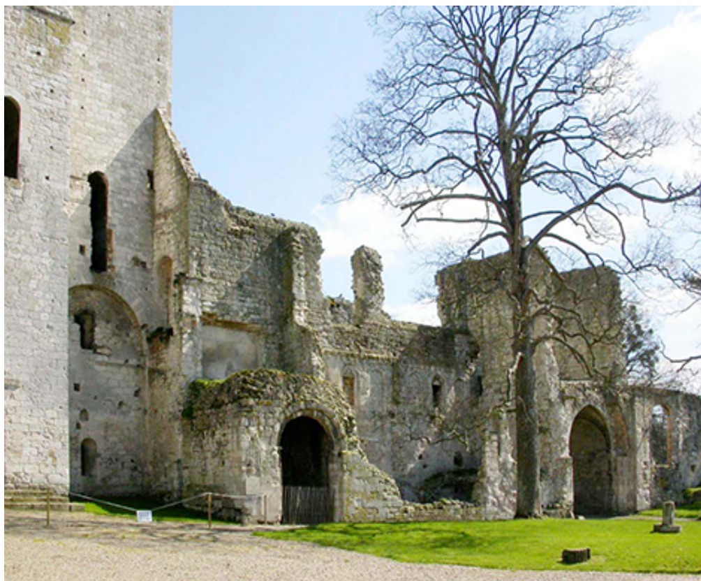
Fig. 6 – La façade occidentale de l'hôtellerie vue du nord-ouest
