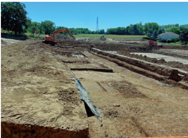
▲ Fig. 4. Le gisement d'Uffheim en cours de décapage (cliché S. Griselin).
