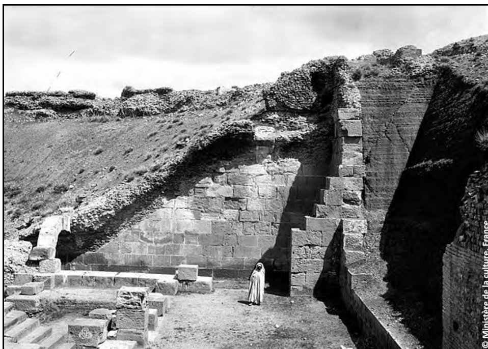
Fig. 04: État des fouilles dans le théâtre en 1893 montrant que le mur de soutènement Sud actuel a été reconstruit après cette date
