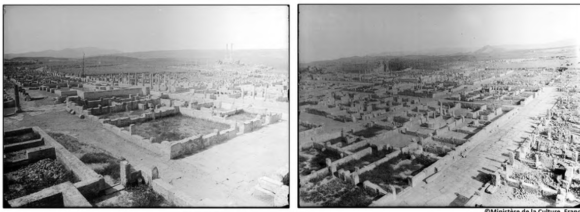
Fig. 2 : Travaux de reconstructions des murs dans le quartier SO, photo prise vers 1902 (cf. amas de moellons en bas à gauche et à droite)
