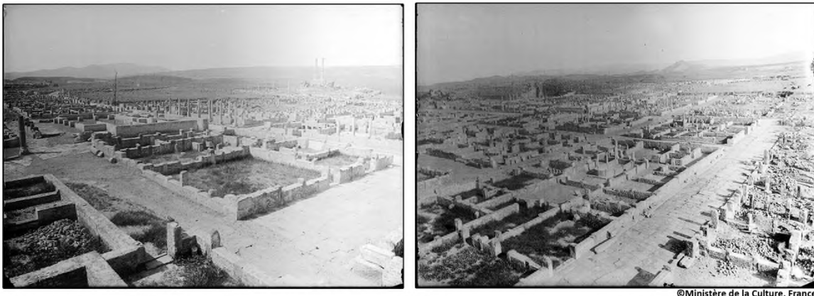
Fig. 2 : Travaux de reconstructions des murs dans le quartier SO, photo prise vers 1902 (cf. amas de moellons en bas à gauche et à droite)
