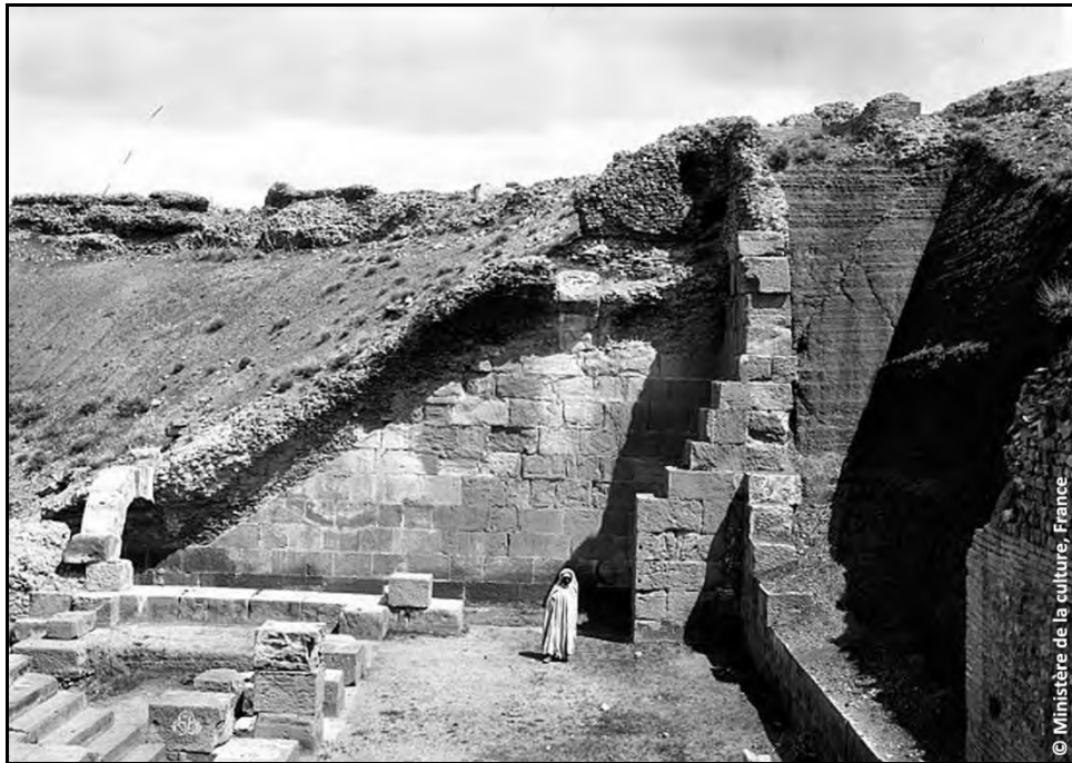
Fig. 04: État des fouilles dans le théâtre en 1893 montrant que le mur de soutènement Sud actuel a été reconstruit après cette date
