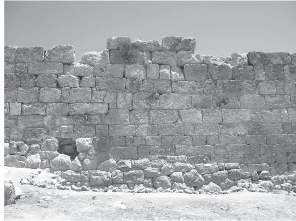
Figure 2. Citadelle, rempart méridional, parement externe (vue vers le nord). L'appareil en polygonal compose le socle avec paliers, parfois altérés ; l'élévation est postérieure (période byzantine) © Mission syro-libanaise de Cyrrhus-Nebi Hourri.
