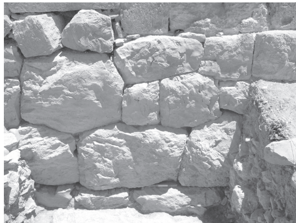
Figure 3. Sondage au pied de la muraille à l'extérieur de la citadelle, détail du parement du socle en polygonal dont le sommet comporte un palier. La maçonnerie repose directement sur le rocher © Mission syro-libanaise de Cyrrhus-Nebi Hourri.
