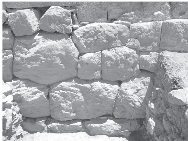
Figure 3. Sondage au pied de la muraille à l'extérieur de la citadelle, détail du parement du socle en polygonal dont le sommet comporte un palier. La maçonnerie repose directement sur le rocher © Mission syro-libanaise de Cyrhus-Nebi Hourî.
