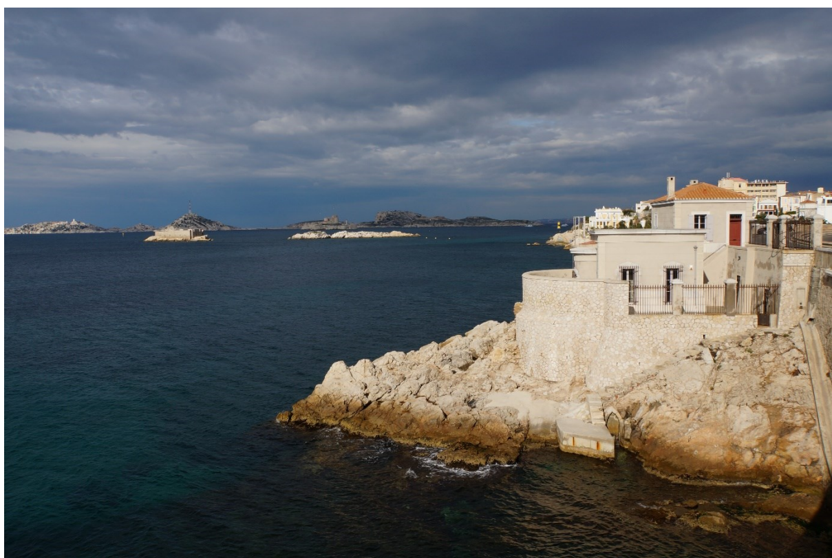
Figure 1 - Les bâtiments du marégraphe de Marseille sont construits en 1883-1884. Ils ont été édifiés pour durer : il suffit d'apprécier le volume total de l'édifice et la qualité de sa construction pour s'en persuader (© Alain Coulomb)
