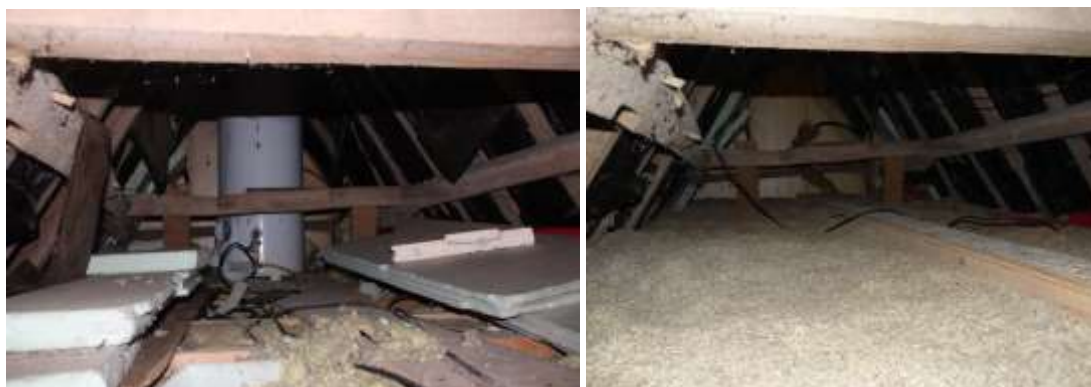
Figure 6 : Grenier avant et après rénovation.
