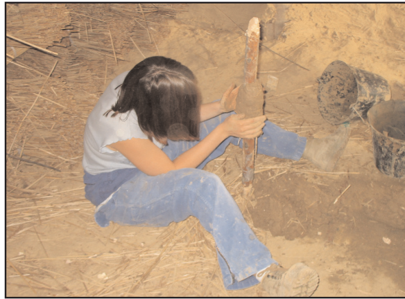
Fig. 173 : les quenouilles sont enduites de torchis
