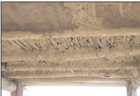
Fig. 168 : application de torchies sur les faces inférieures du plancher
