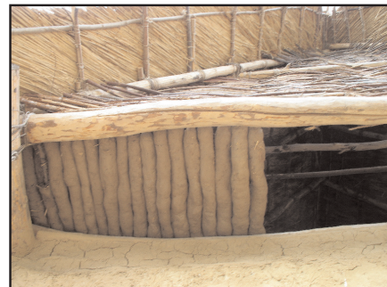
Fig.174 a et b : elles sont posées par le dessus et collées ensemble
