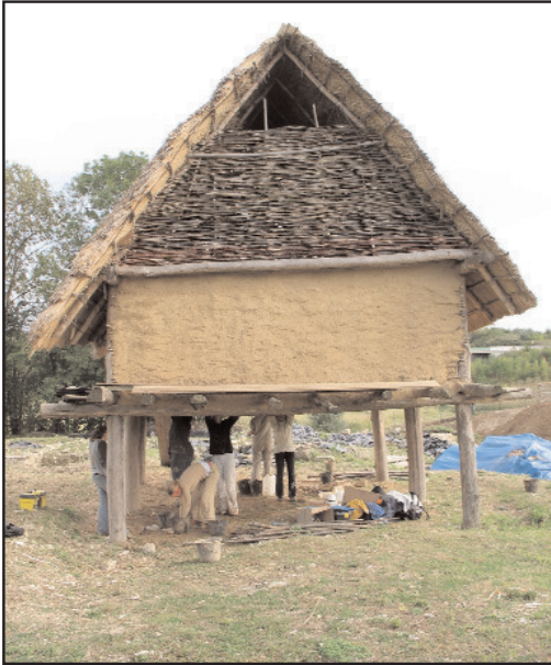
Fig.169 : réalisation du torchis sous le plancher formé de perches
