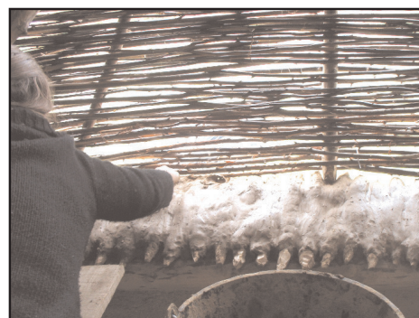
Fig.175 : elles sont ensuite lissées intérieurement et extérieurement
