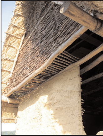
Fig.172 : pose "a blanc" des quenouilles coupées à la dimension
