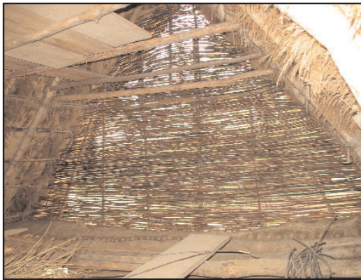
Fig.169bis : réalisation du pignon clayonné
