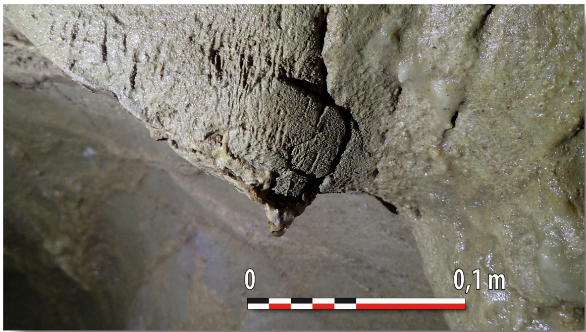
Figure 17 : état des parois dans la galerie des Chauves-Souris. Corrosion d'un pendant de la paroi. Les structures sparitiques du calcaire ont une moindre dissolution que la calcite. L'accroche des chauves-souris sur la paroi provoque également une érosion mécanique (cliché © Didier Cailhol).
