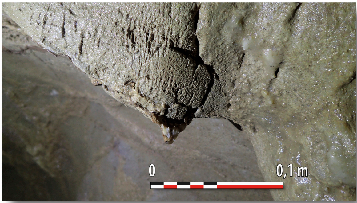
Figure 17 : état des parois dans la galerie des Chauves-Souris. Corrosion d'un pendant de la paroi. Les structures sparitiques du calcaire ont une moindre dissolution que la calcite. L'accroche des chauves-souris sur la paroi provoque également une érosion mécanique (cliché © Didier Cailhol).
