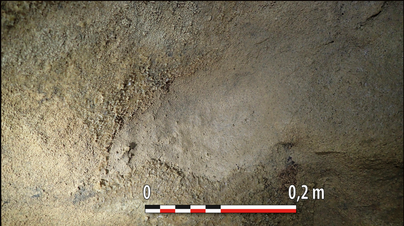
Figure 14 : état des parois dans la galerie des Chauves-Souris. Encroûtement de calcite formé à partir des films d'eau issus de la condensation (cliché © Didier Cailhol).
