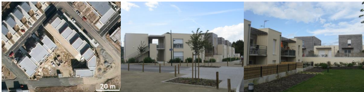
Vue aérienne de l'îlot, composé de deux bâtiments articulés autour d'une cour ouverte (ici en chantier...)
