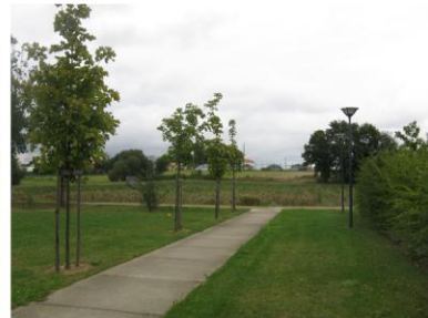
Bassin de rétention dimensionné pour l'orage du millénaire...
