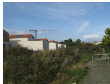
Arrière d'opération donnant sur un chemin municipal (Bouguenais)
