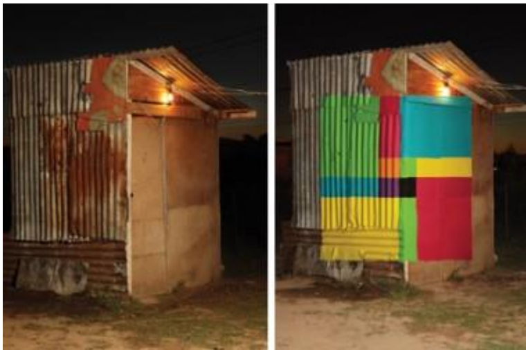
Baño, acción en Barrio Nuevo Alberdi.
