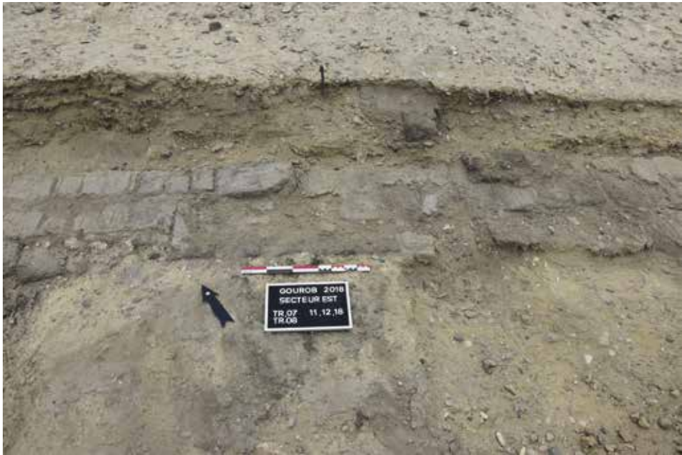
Fig. 3. Détail des briques crues du mur sud. Photo M. Yoyotte.
