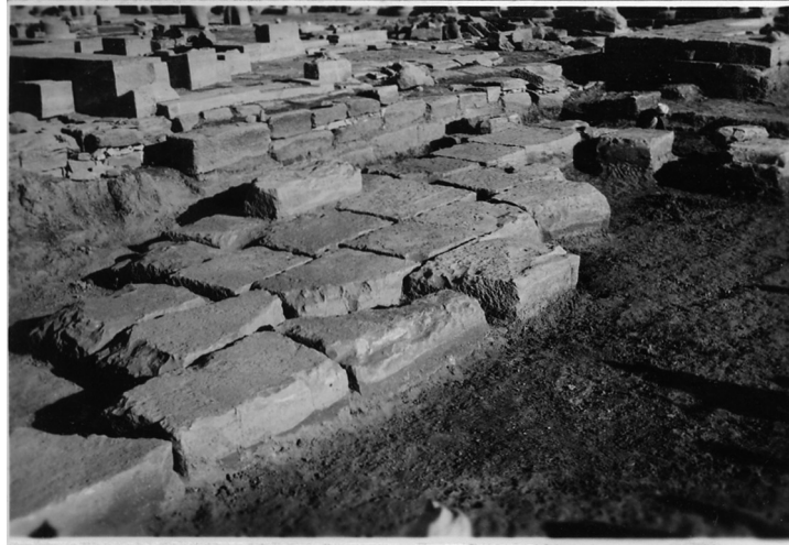
Fig. 7 : Vue de la plate-forme de fondation calcaire (photographie Cl. Robichon, © Archives Collège de France).
