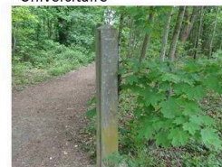
Photo 6: Poteau de l'entrée du parking
