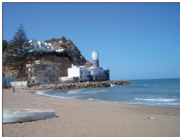
Photo 10. — Enrochement autour de l'aquarium de Béni-Saf (cliché GHODBANI, 2009).
