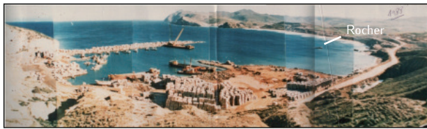
Photo. 2. — Chantier du port en 1988. On remarque la position du rocher en pleine mer avant l'édification de la jetée est (cliché DTP d'Aïn TÉMOUCHENT, 1988).
