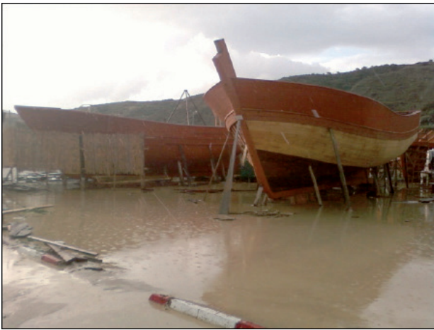
Photo. 1. — Chantier naval inondé et éboulement, Port de Bouzedjar, novembre 2010.
