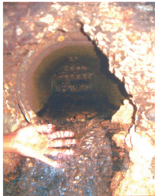
Photo. 3. — Dispositif de captage d'une source à débit notable.
