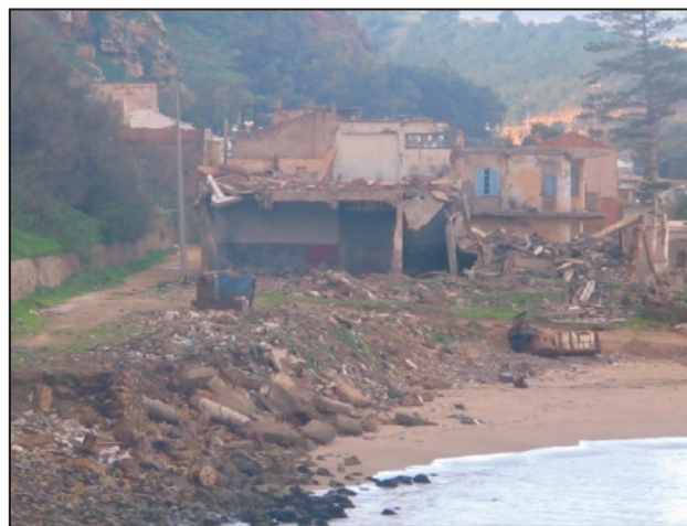
Photo 9. — Risque d'inondation et maisons détruites dans l'ancien quartier de la Marine (cliché GHODBANI, 2008).
