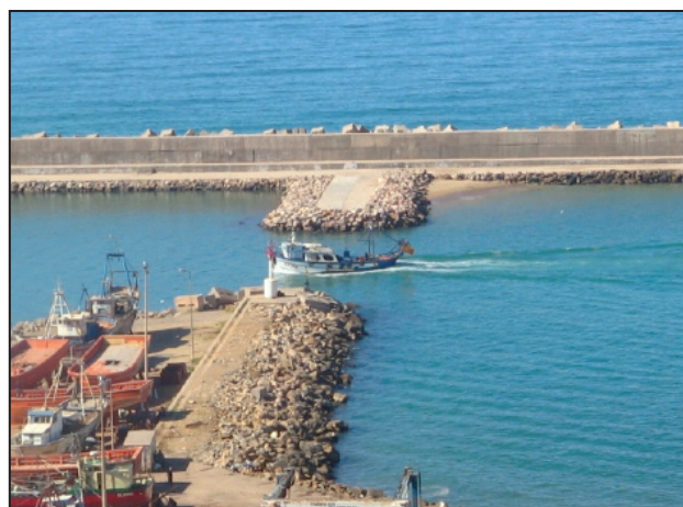
Photo 11. — Un nouvel épi sur la face interne de la jetée principale pour limiter l'ensablement du bassin portuaire (cliché GHODBANI, 2009).
