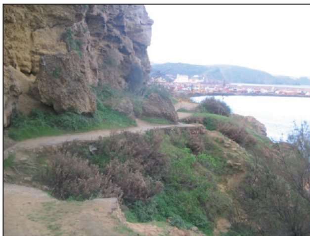
Photo 8. — Démantèlement de la route de la Marine (cliché GHODBANI, 2007).
