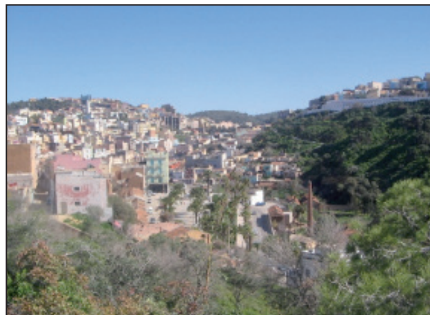
Photo 7. — L'urbanisation de Béni-Saf sur les bassins versants : les oueds ici sont colmatés ou déviés (cliché GHODBANI, 2009).
