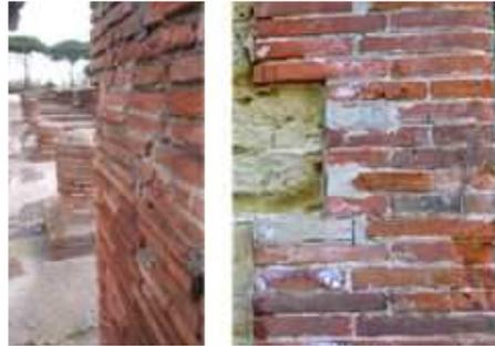
Figure 14 - Comparaison des briques romaines (à gauche, site archéologique d'Ostia Antica 3<sup>es</sup>. av. JC) et foraines (à droite, pont ligne de chemin de fer Castres-Albi 1870)
