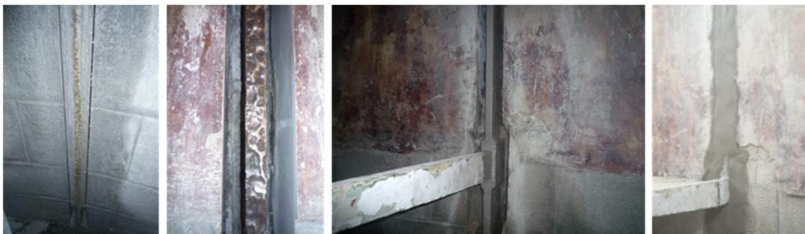
Figure 97 – Vue des montants d'ancrages de lanterne avant, pendant et après réparation (photos CEREMA)
