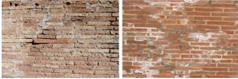
Figure 13 - Comparaison des briques romaines (à gauche, Rome antique) et foraines (à droite, pont ligne de chemin de fer Castres-Albi 1870)
