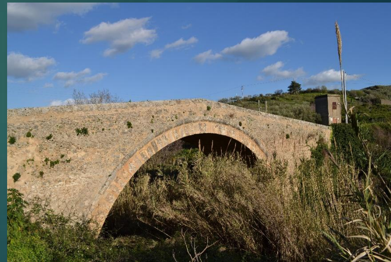
Unica arcata, intradosso in conci squadrati e ghiera con blocchi disposti di testa, conclusa all'esterno da un cordone lapideo
