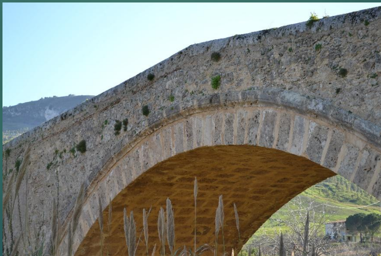
Unica arcata, intradosso in conci squadrati e ghiera con blocchi disposti di testa, conclusa all'esterno da un cordone lapideo
