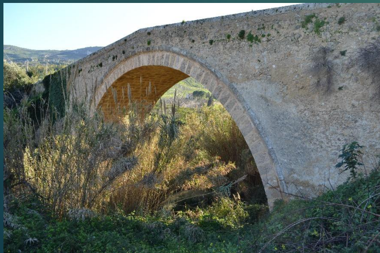
Unica arcata, intradosso in conci squadrati e ghiera con blocchi disposti di testa, conclusa all'esterno da un cordone lapideo
