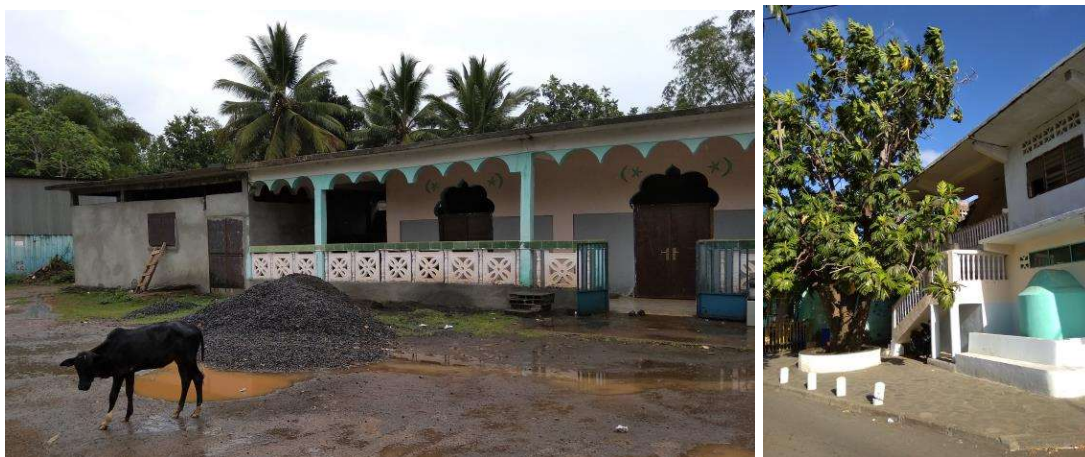
Mosquées de quartier de Dzoumogné et de Mamoudzou (quartier M'gombani) [© Hugo Bréant].
