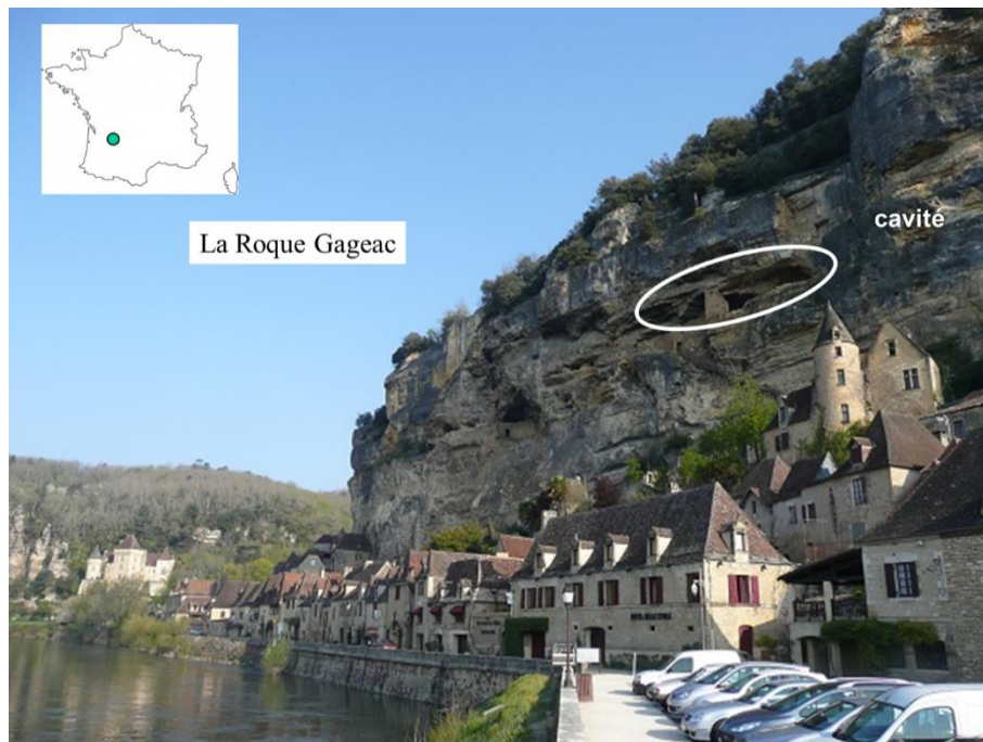
Figure 1 : Site de la Roque Gageac et localisation de la cavité dont le toit s'est en partie effondré en 2010
