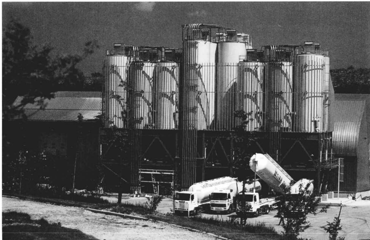
Figure 10 : Usine de stabilisation de résidus ultimes : Villeparisis (France Déchets)
