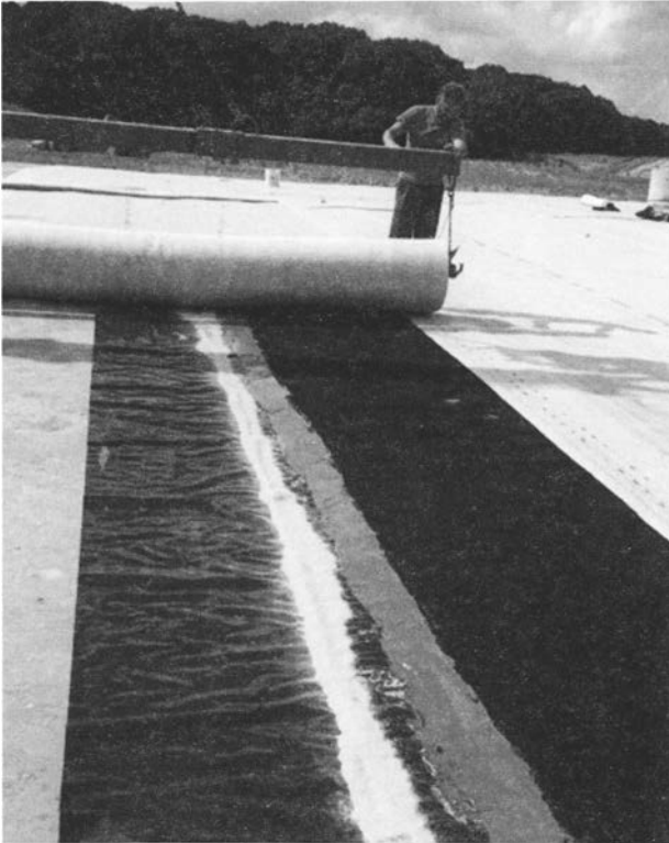
De gauche à droite sont visibles : le sol support, le film étanche, un cordon de bentonite en vrac, une bande de bentonite en pâte, le géotextile drainant, le Bentomat en partie médiane de la bande drainante
