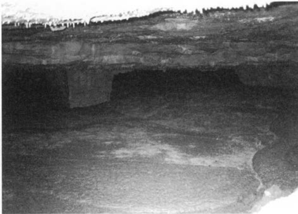
Figure 5 : Carrière remplie avec le mortier de mâchefers stabilisés
