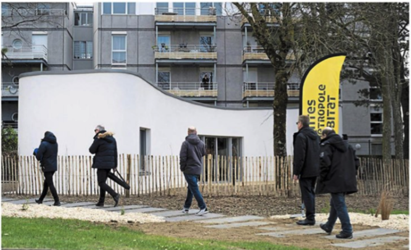
En septembre 2017, la maison Yhnova a surgi de terre, quartier de la Bottière, en un temps record (54 heures), grâce à la technologie de l'impression 3D. Le bras d'un robot a déposé une triple paroi en polymère et béton servant à la fois de coffrage, d'isolant et de mur. Des locataires ont pris possession des lieux l'été dernier. Photo archives PO / Olivier Lanvaan
